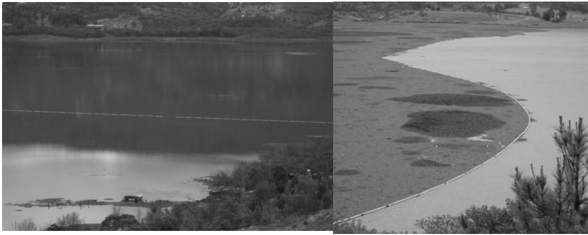
Figura 7.1-6 Estructura para el control de dispersión de buchón de agua en los embalses de Tominé (izquierda) y Muña (derecha)
