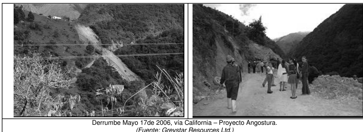
Foto 3.2-5 Derrumbe Mayo 17 de 2006, vía California – Proyecto Angostura.
