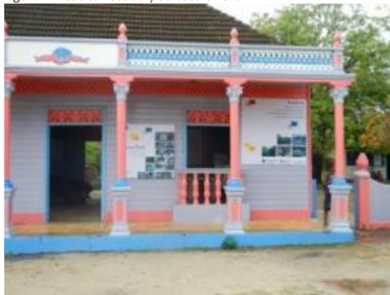
Figura 17 Casita rosada y su casa anexa
